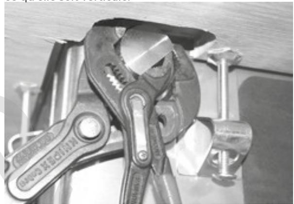
**ATTENTION :** Utiliser impérativement la deuxième pince de manière à ne pas endommager les entrées de filetage, sinon tu auras des difficultés à monter les tuyaux flexibles et à les rendre étanches ! Vissez ensuite avec précaution les deux tuyaux flexibles dans la robinetterie et serrez-les uniquement à la main, pas avec une pince ! Veillez à ce que les joints toriques soient correctement positionnés. L'eau chaude et l'eau froide sont marquées par des points de couleur.
